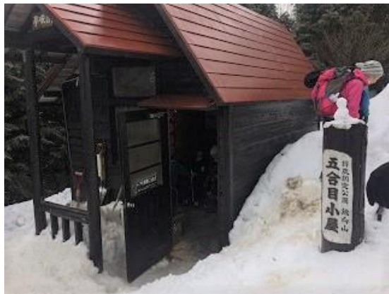
2. 綿向山を愛する会が管理する小屋 立派に整備されている
