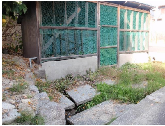
11. 越水の井戸二か所あり。崖の下にある。いまも清水が湧いている。越水は小清水の転訛とのこと。
