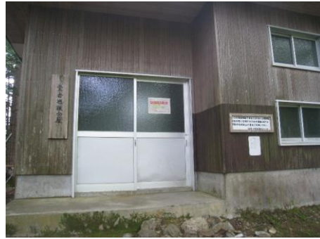
常蔵避難小屋
