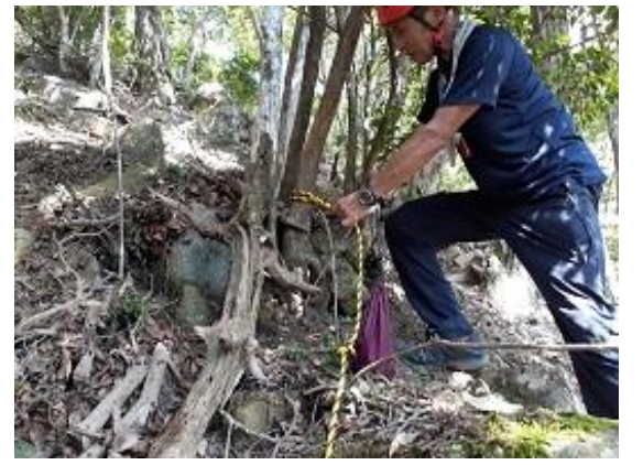
18. 頂上直下にフィックスロープを設置しているところです。クローブ・ヒッチと針金でしっかり固定しました。
