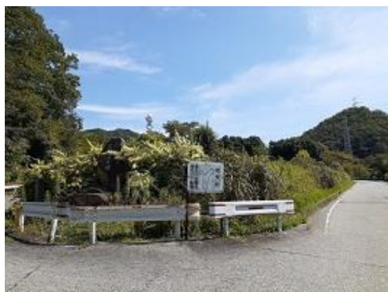
1. 猪名川変電所、右方向行きます。
