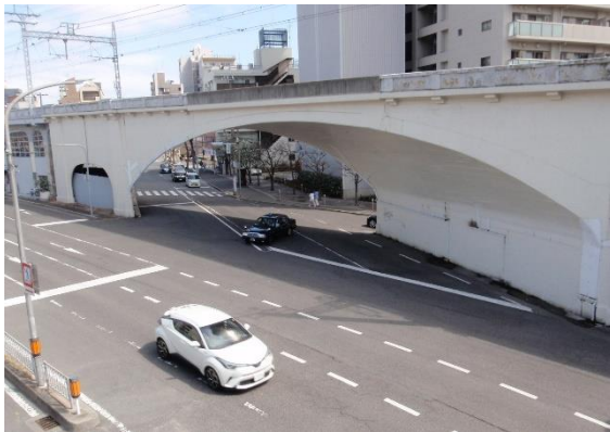
アーチ高架橋は三ヶ所ある。
