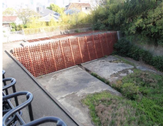
北野川の起点山側にある沈砂池
