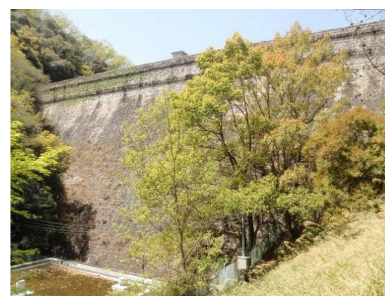
五本松堰堤。明治33年竣工。高さ33m
