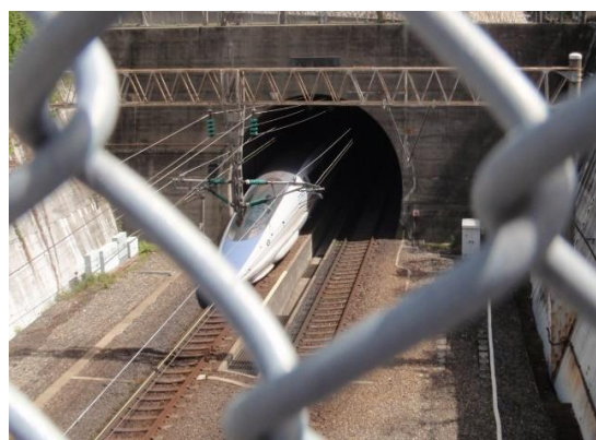
六甲トンネルを出る新幹線
