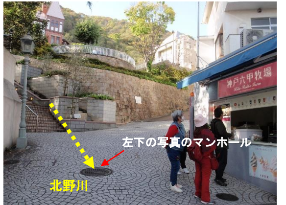
→ 北野川は地下河川として道路地下を流れ下る
