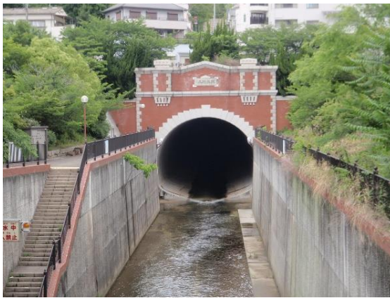
湊川隧道下流側 この写真以降は二日後に撮影したものです
