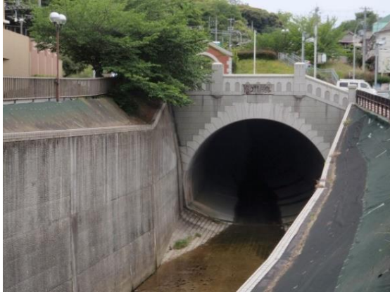
湊川隧道上流側
