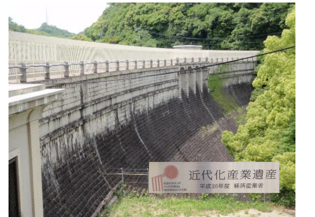
鳥原立ヶ畑堰堤。明治 38 年竣工
