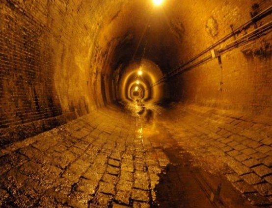
隧道は天井と側面はレンガ、底は石
