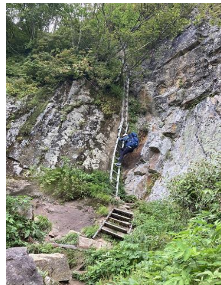
3. 3連アルミはしご 冬季には雪崩損壊防止のため外される
