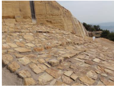
城壁の外の敷石
