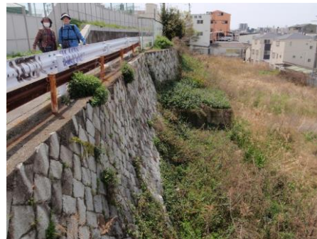
この先も古い石の擁壁が続く。 擁壁の下部に有名な湧き水があるが柵で囲われて入れない
