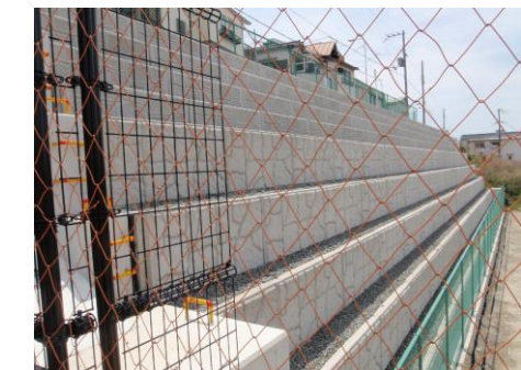
今はコンクリートで完璧に補強
