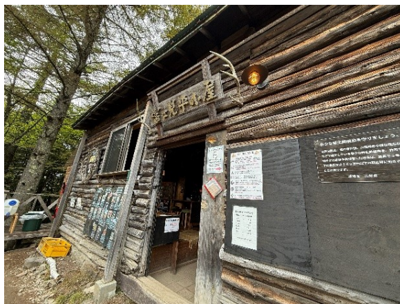
14. 小屋組が泊まっていた富士見平小屋
