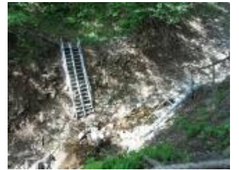
道が崩れて梯子が渡り代になっていた。
