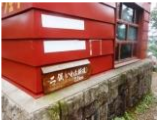
避難小屋前から、樹林帯に入る。
