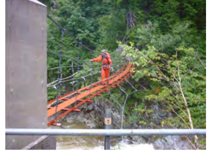
42. 薬師沢小屋手前の吊橋
