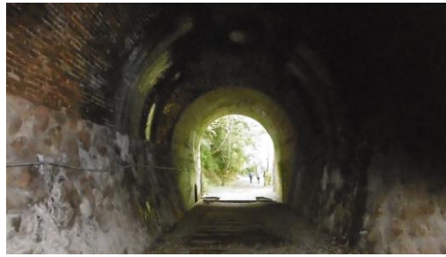
② トンネル出口
