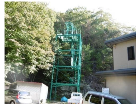
③同左登山口に設置された クライミング練習用鉄骨架台
