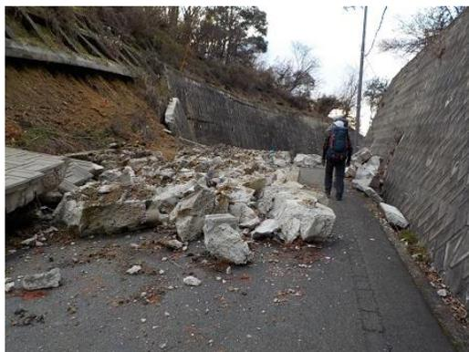
25. 夏の大雨で法面の擁壁が崩れていた
