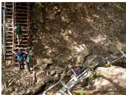
数年前の水害で崩落したところ
