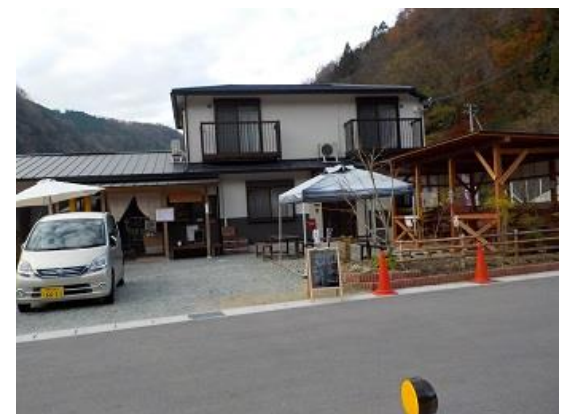
3. 水害後に地上げされたところに再建された「畑熊商店」。また下山後に咽を潤すことができるようになった。
