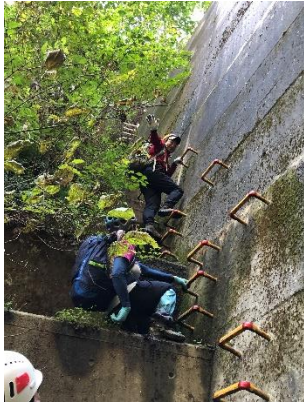
⑨水晶谷第3堰堤
