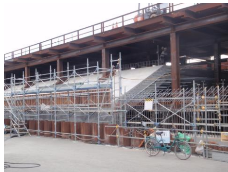
淀川左岸線トンネル工事中
