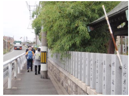
玉垣の内側は堤防の盛土が残っている。すぐ左に淀川の堤防が見える。
