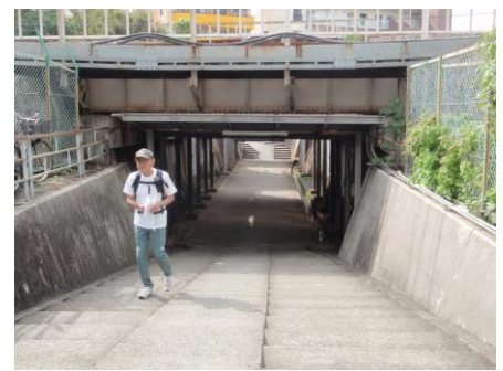
旧中津川橋梁跡、9連橋のひとつ 橋は日本最初の鍊鉄製トラス橋という
