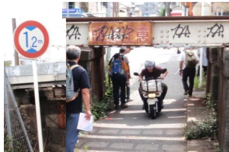
桁下1.2mのガード下を身をかがめてくぐる JR神戸線とJR北方貨物線で形造られるデルタ線の盛土の下が一般通路になっている
