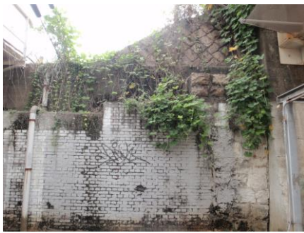
橋梁のいが積み基礎が残る
