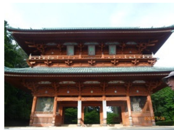
9. 大門 高さ25.1M 重要文化財
