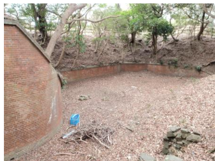
第1砲台跡 基礎のみ残る
