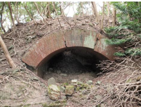
第2砲台砲弾庫跡(破壊が激しい)
