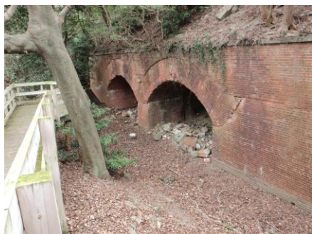
第1砲台砲弾庫跡(レンガ製)
